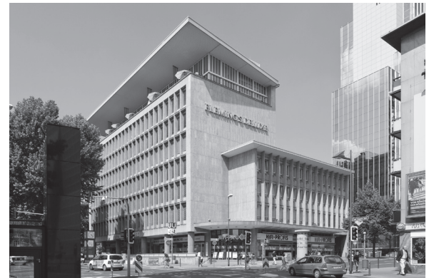
Bayer-Hochhaus in Frankfurt, 1953
