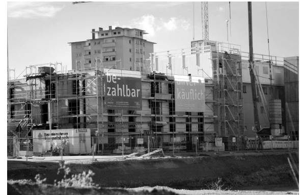
3-Häuser-Projekt, Freiburg (Quelle: www.3hauserprojekt.org/bautagebuch/ )
